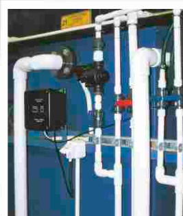
Завод гальванических покрытий, Польша
